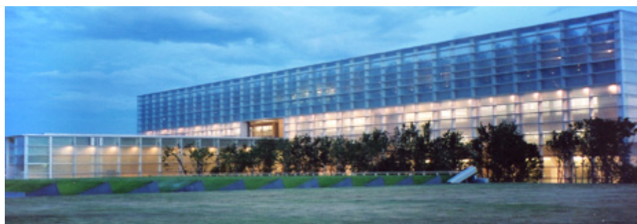
Рис. 1.1а. Здание Кансаи-кан
